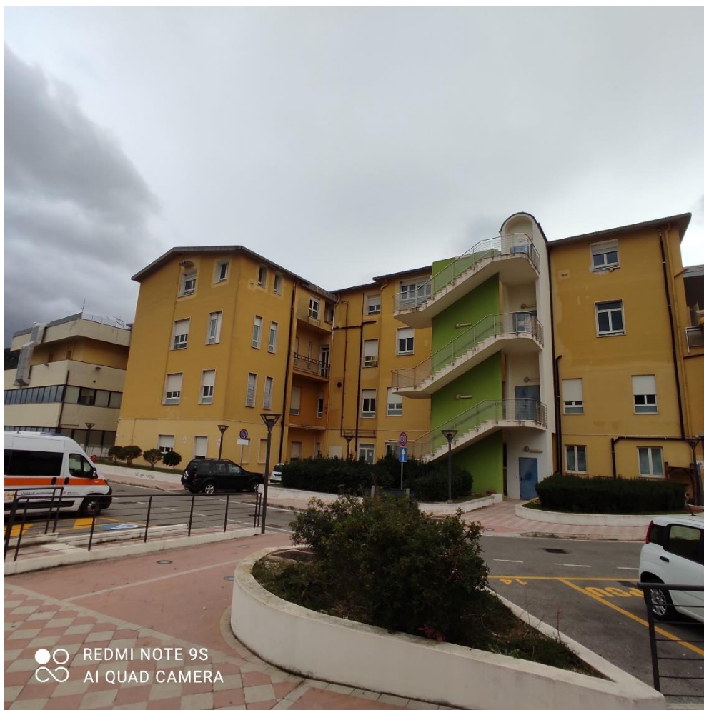
Vista ingresso cortile interno (lato a valle)
