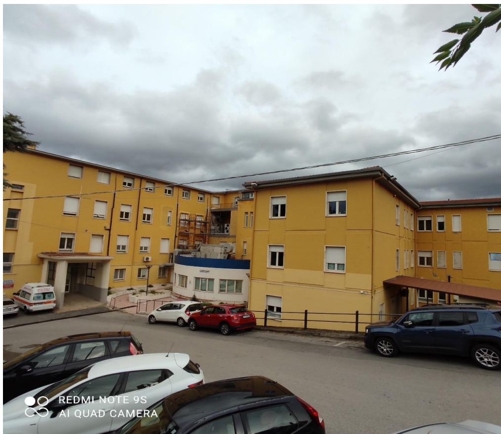
Vista vecchio ingresso
