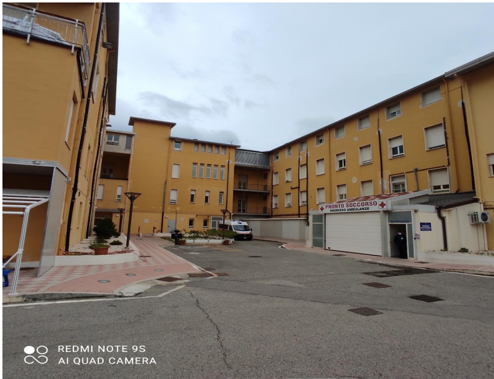
Vista ingresso Pronto Soccorso (cortile interno)
