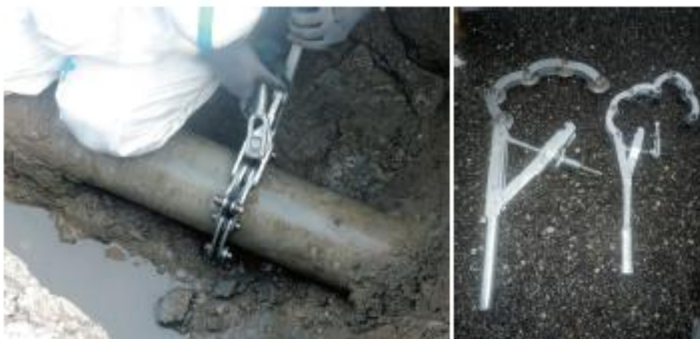
Figura 8 - Taglio di una tubazione mediante tagliatubi manuale a catena.
