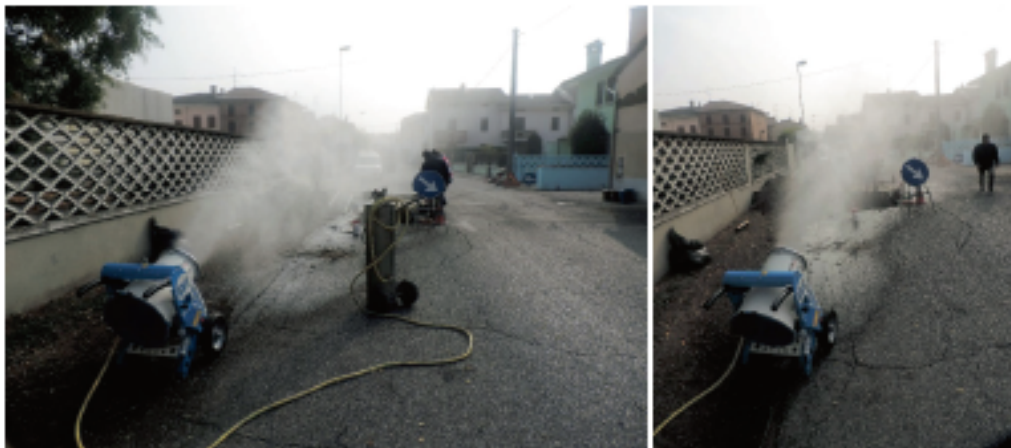
Figura 5 - Cannone nebulizzatore nell'area d'intervento.
