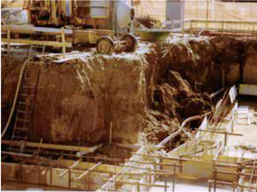
Parete di scavo con inclinazione errata ed evidente franamento
