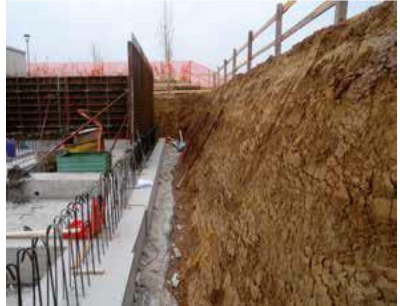
Parete di scavo con corretta inclinazione
