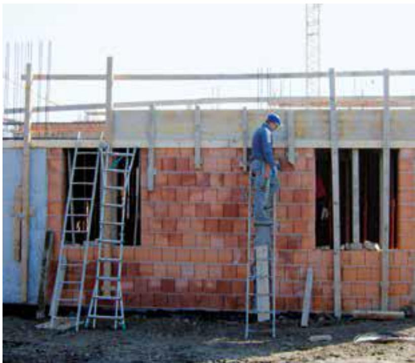
Scala non fissata o trattenuta. Presa non sicura
