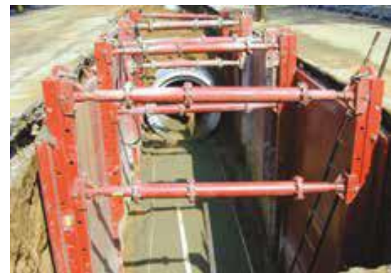
Armature di sostegno
