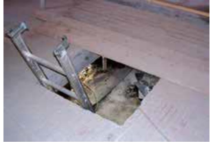
Scala sporgente e fissata alla base
