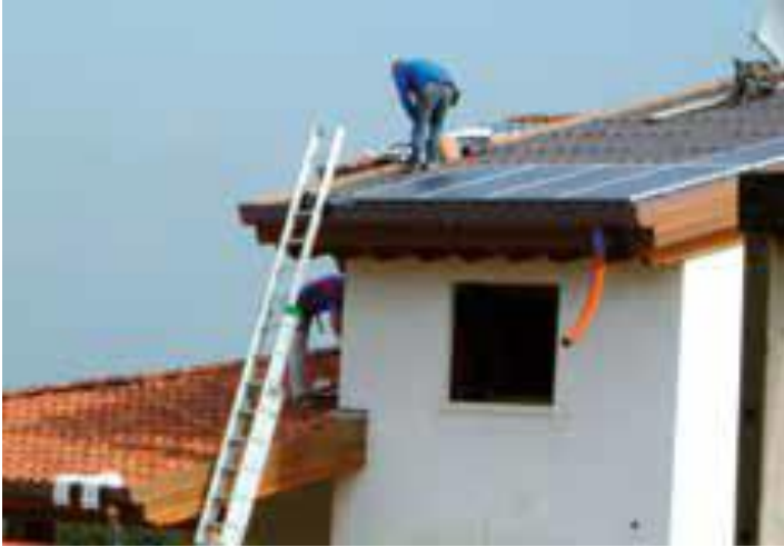
Scala non fissata. Assenza di protezione in quota
